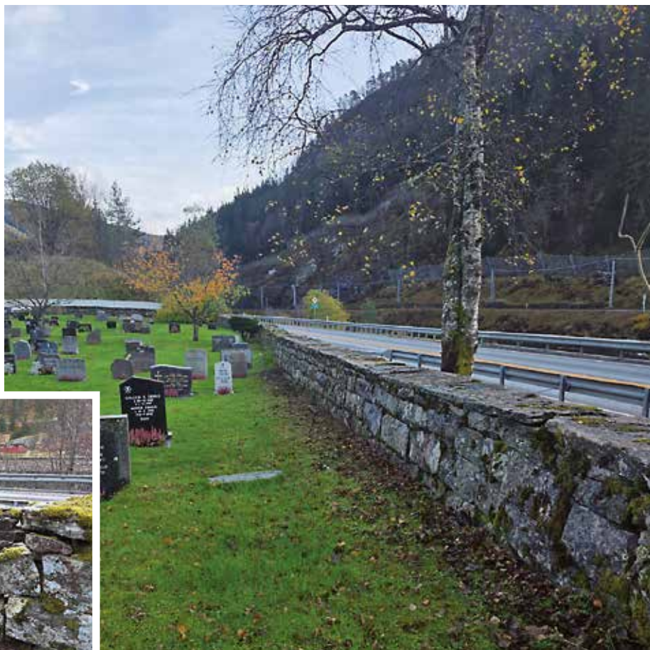
Til venstre muren mot E16 før utbetring. Over muren mot E16 etter at arbeidarane frå Stibbyggjaren har reparert den.
